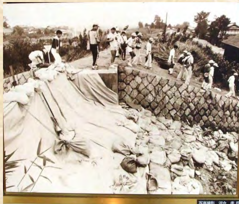
「十連坊堤防」の補強の様子 海津市歴史民俗資料館展示写真より
