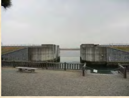
川口水門 (マイタゲート)
