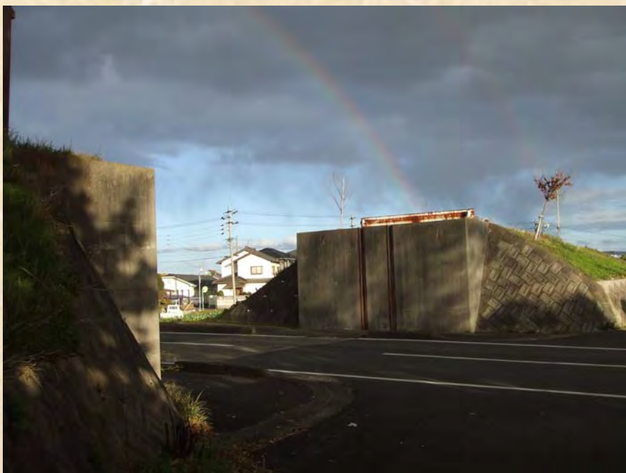
十連坊堤防(切割部) ※写真は事前調査時に撮影
